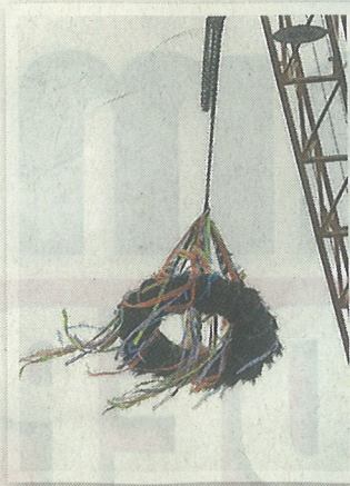
Mit einem Kran wurde der Richtkranz hoch aufs Dach gebracht.
